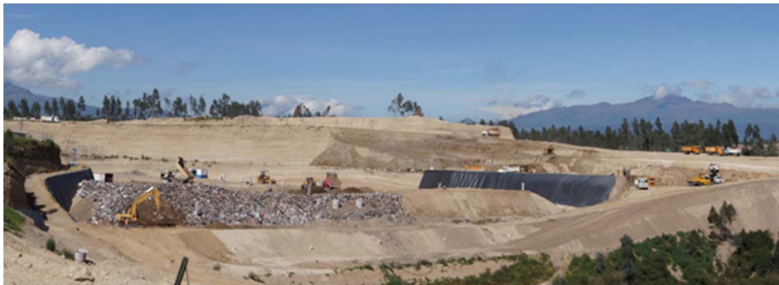
Relleno Sanitario de Quito
