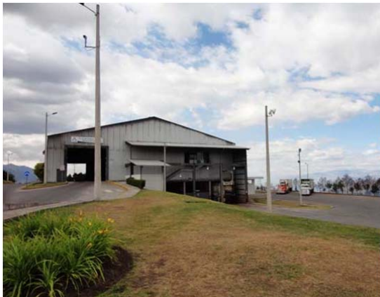
Estación de Transferencia Sur (ET1)
