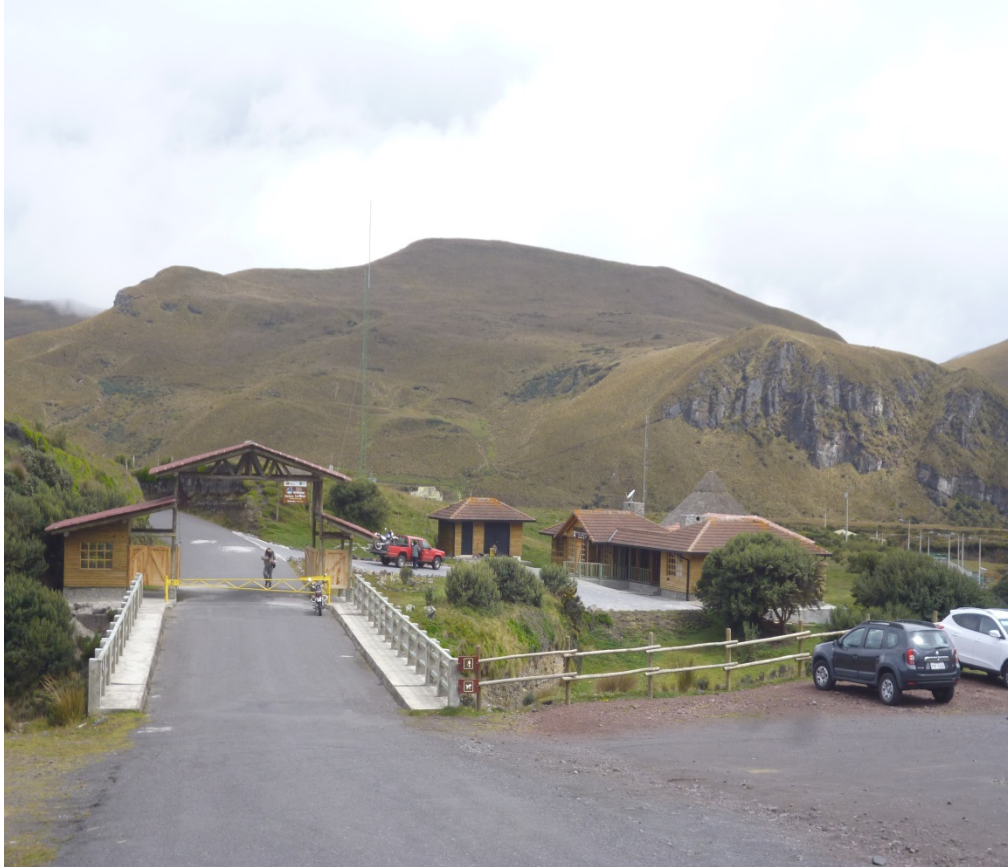
Foto: Jacobus Woudman Casa de guarda parques
