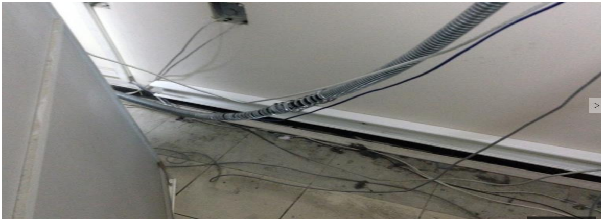
Figura 13: Paso Nueva Canaleta 2 (Oficina Decano)
