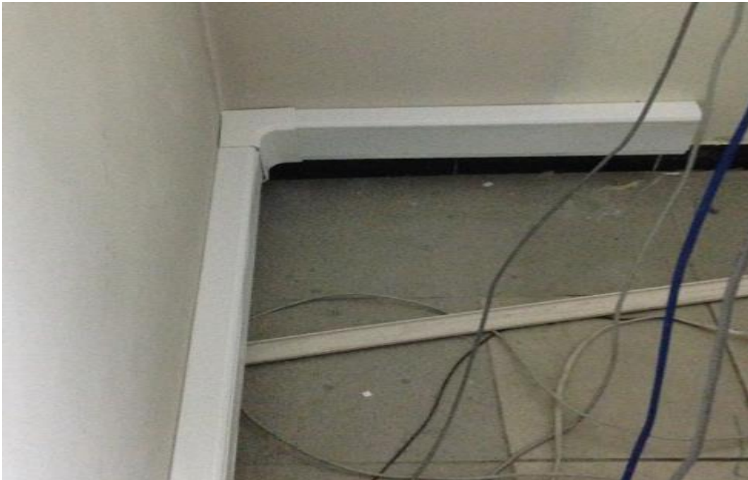
Figura 14: Paso Nueva Canaleta 3 (Oficina Decano)
