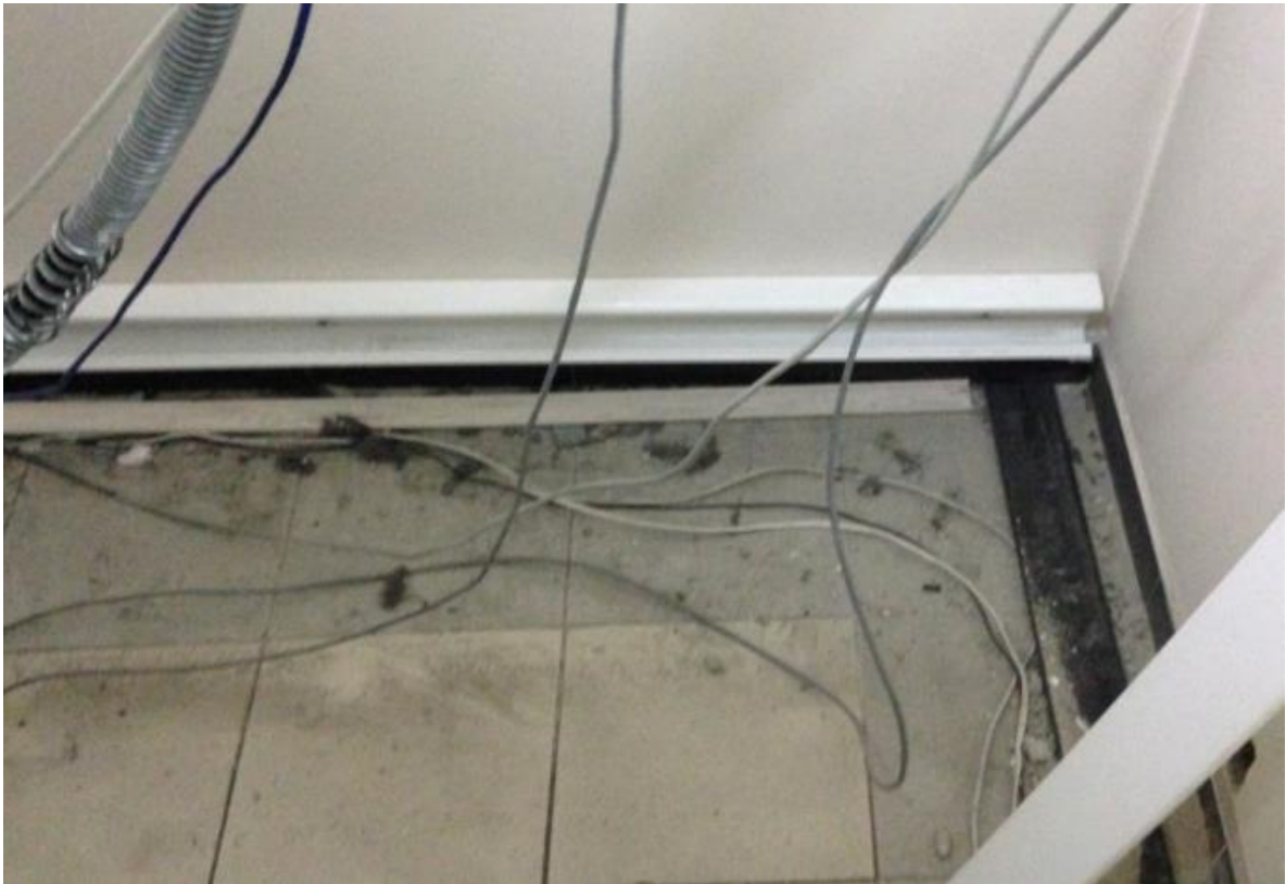
Figura 12: Paso Nueva Canaleta 1 (Oficina Decano)
