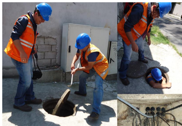
Figura 3.8 Levantamiento de canalización y Registro fotográfico.
