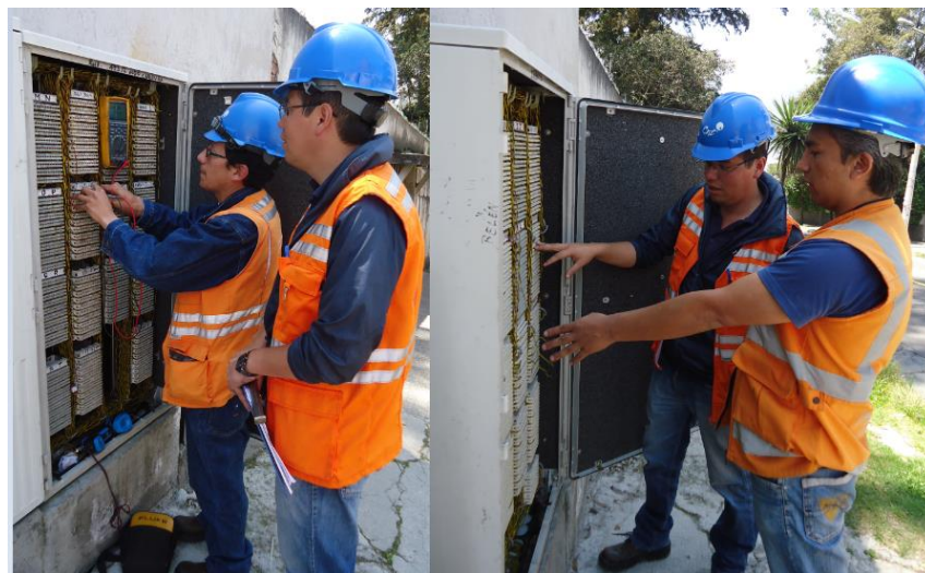
Figura 3.1 Revisión previa y toma de medidas en el Armario
