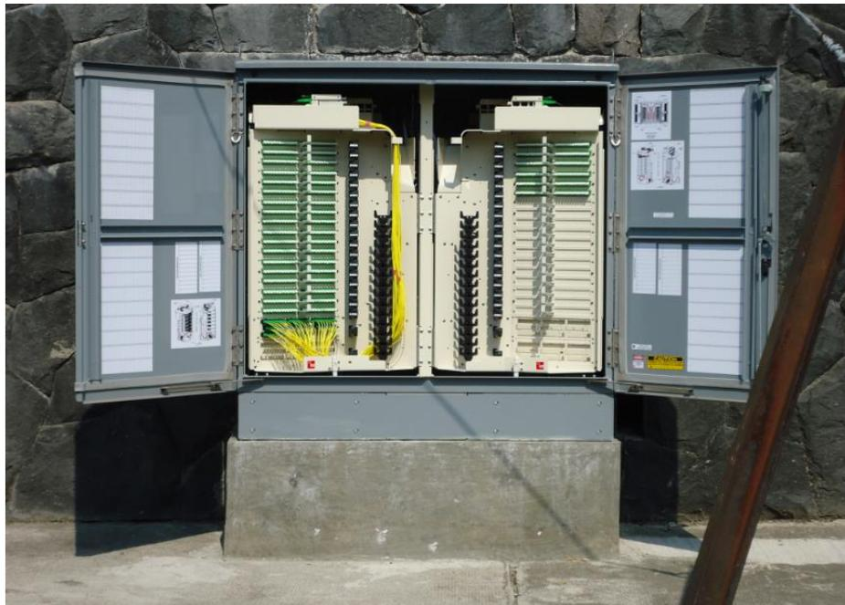
**Figura 2.34 Armario GPON - FDH, instalada con su respectiva base.**
