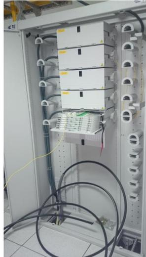
**Figura 2.30 Rack de ODF's de una de las OLT de la CNT EP**
