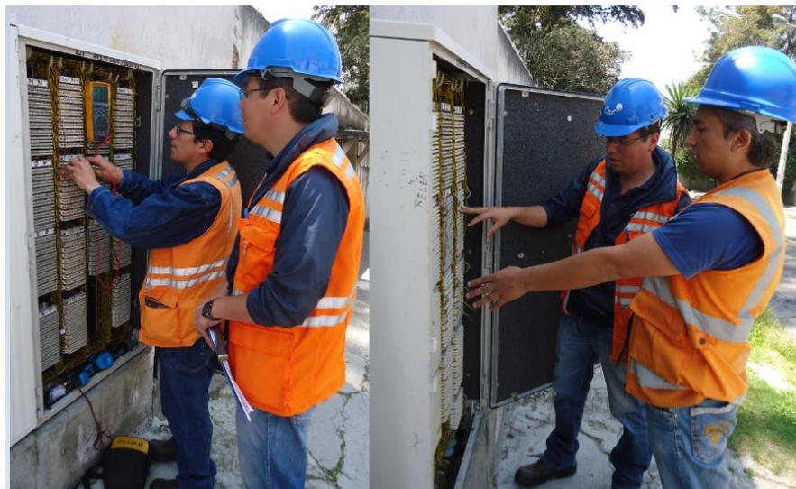
**Figura 3.2 Revisión previa y toma de medidas en el Armario**
