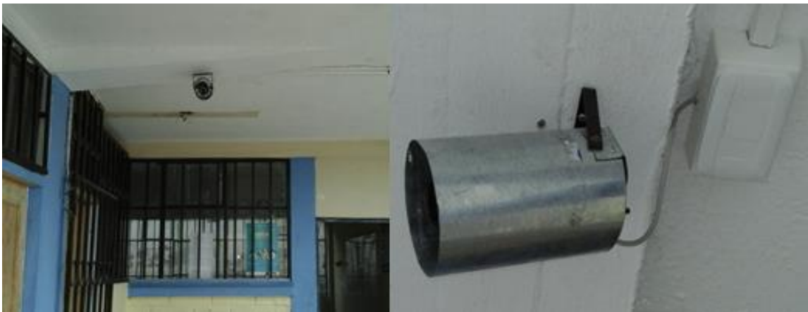
Figura 42. Cámara 1, pasillos del bloque 1 y escalera.
