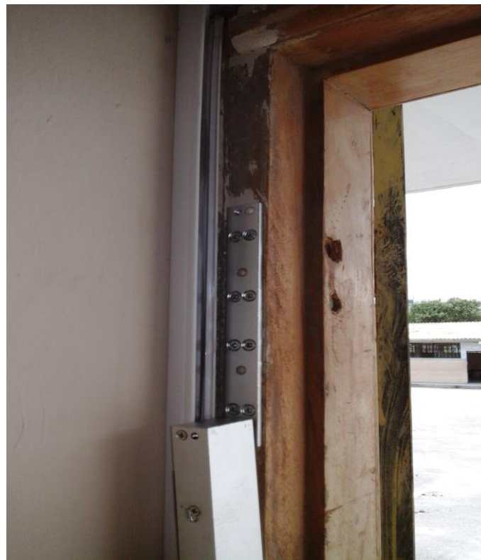
Colocación de la cerradura electromagnética.
