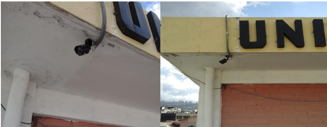
Figura 43. Cámara 2, ubicada sobre la inspección general.
