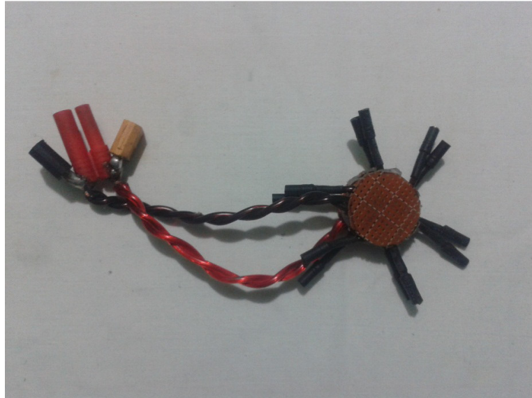
Figura 3.50: Distribuidor de energía
