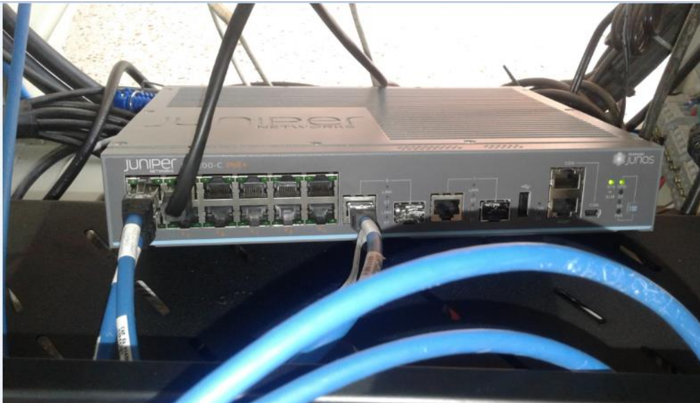
Figura 20. Instalación de switch.
