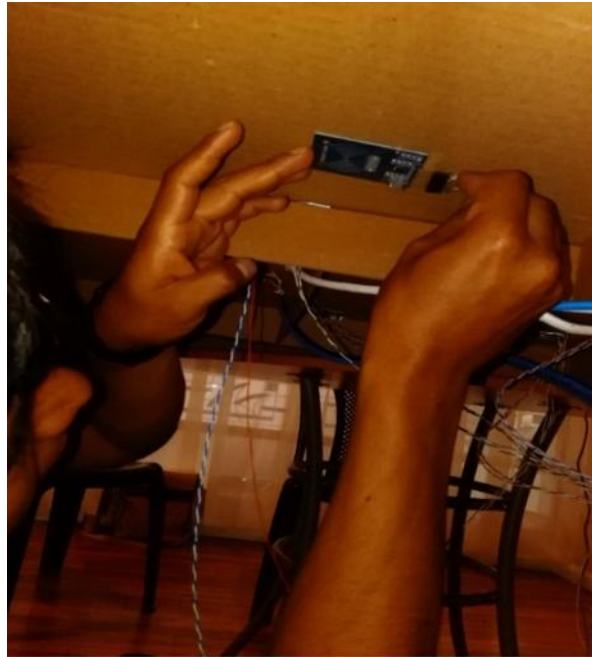
Figura 46. Montaje de Lectores
