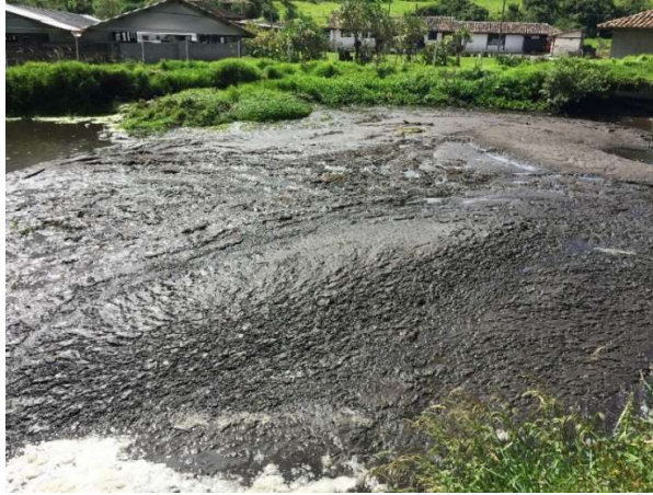
Figura 64 Desarenado de laguna de captación Fuente: Elaborador por el Autor
