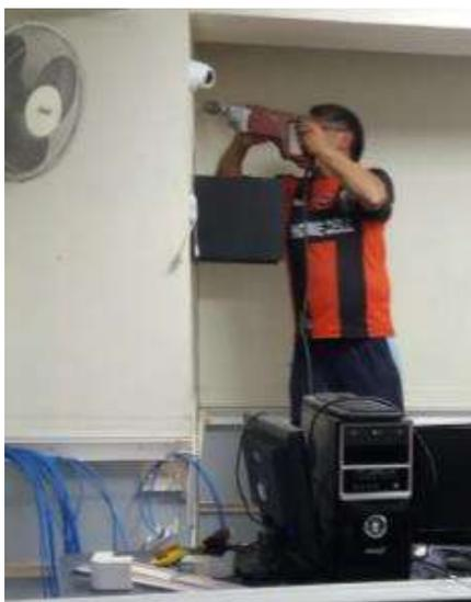
Figura.37: Instalación de soporte de pared y equipos en Rack
