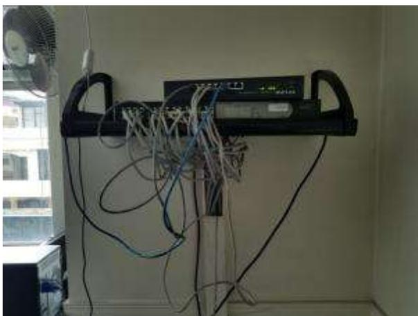
Figura.17: Estado de las instalación del Switch y cableado estructurado.
