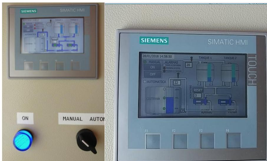
Figura 3.56. Prueba de la pantalla HMI Visualización del proceso en estado OFF.
