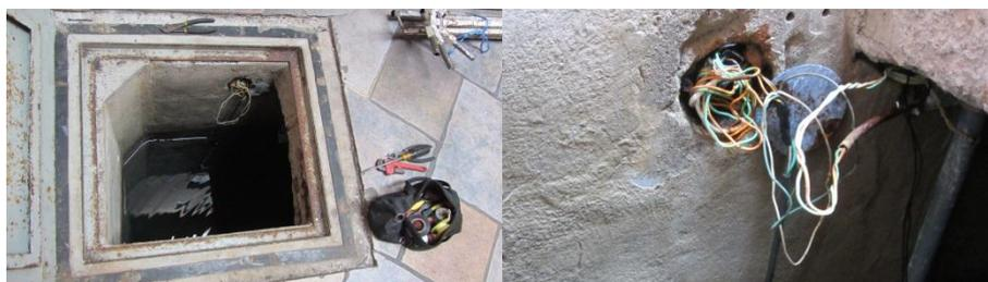
Figura 3.49. Cableado e instalación para sensores.
