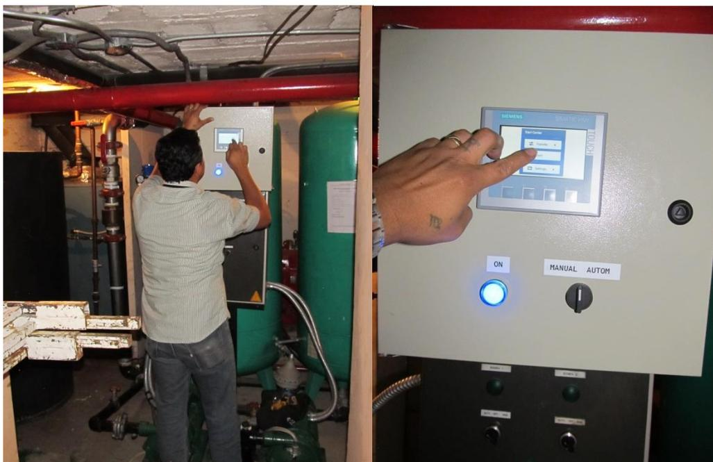
Figura 3.55. Iniciado el sistema de monitoreo en la pantalla HMI.
