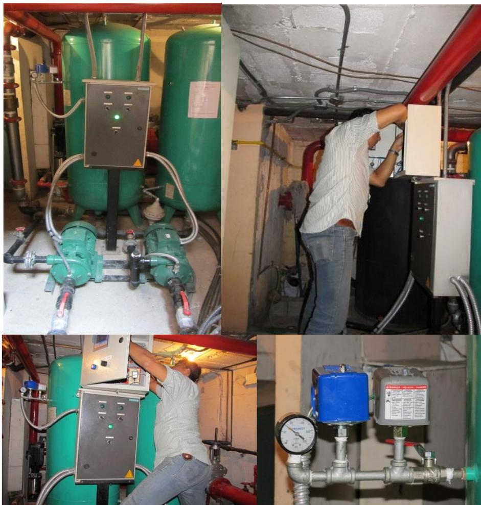
Figura 3.53 Instalación del Tablero de Monitoreo en el cuarto de bombas del edificio
