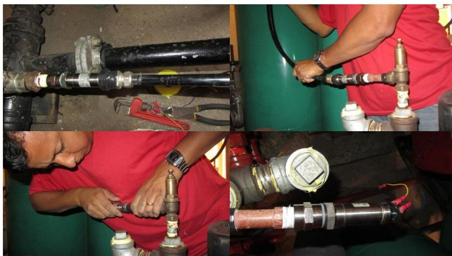
Figura 3.52. Entubado y Cableado para sensores de presión.
