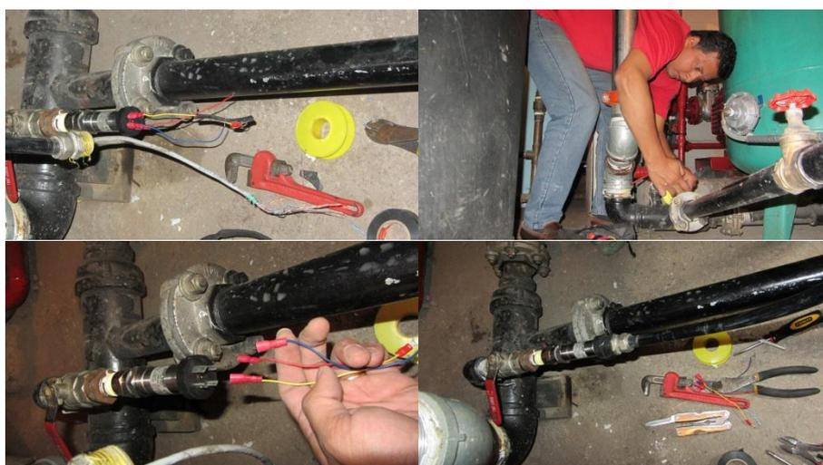
Figura 3.51 Montaje sensores de presión en cuarto de bombas.
