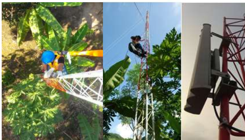
Figura. 3. 41. Instalación AP y antenas sectoriales
