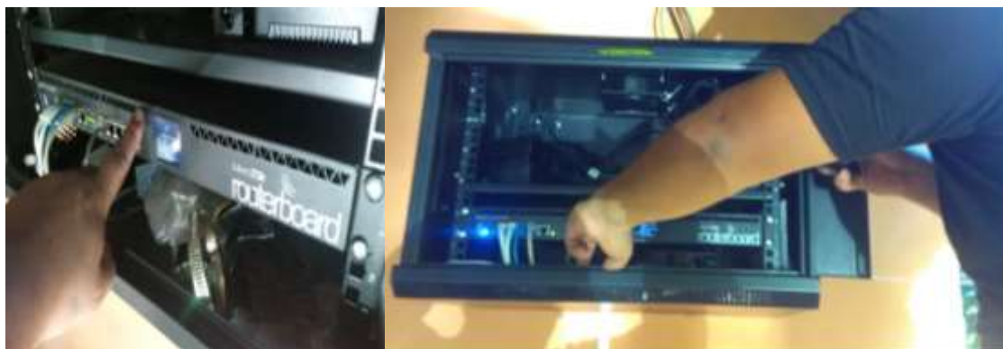
Figura. 3. 42. Instalación router principal en el rack
