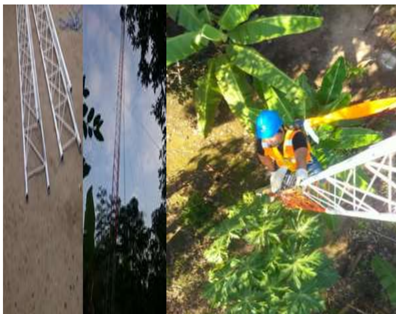
Figura. 3. 37. Instalación torre soportada por tensores
