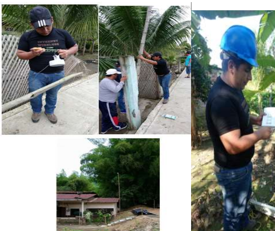
Figura. 3. 51. Instalación equipo final CPE
