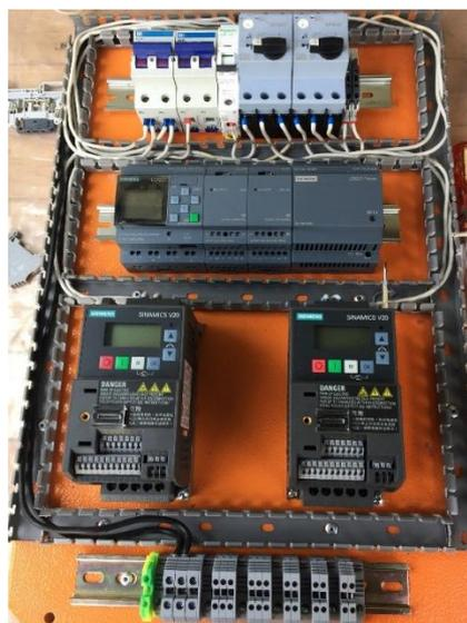
**Figura. 4. 7. Cableado de la parte de control del tablero**
