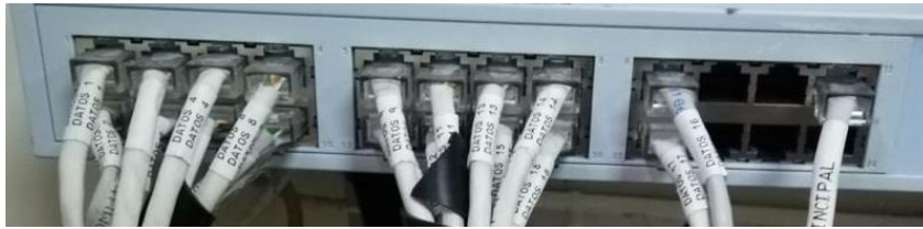
Figura 43 Etiquetado de puntos de cable de red
