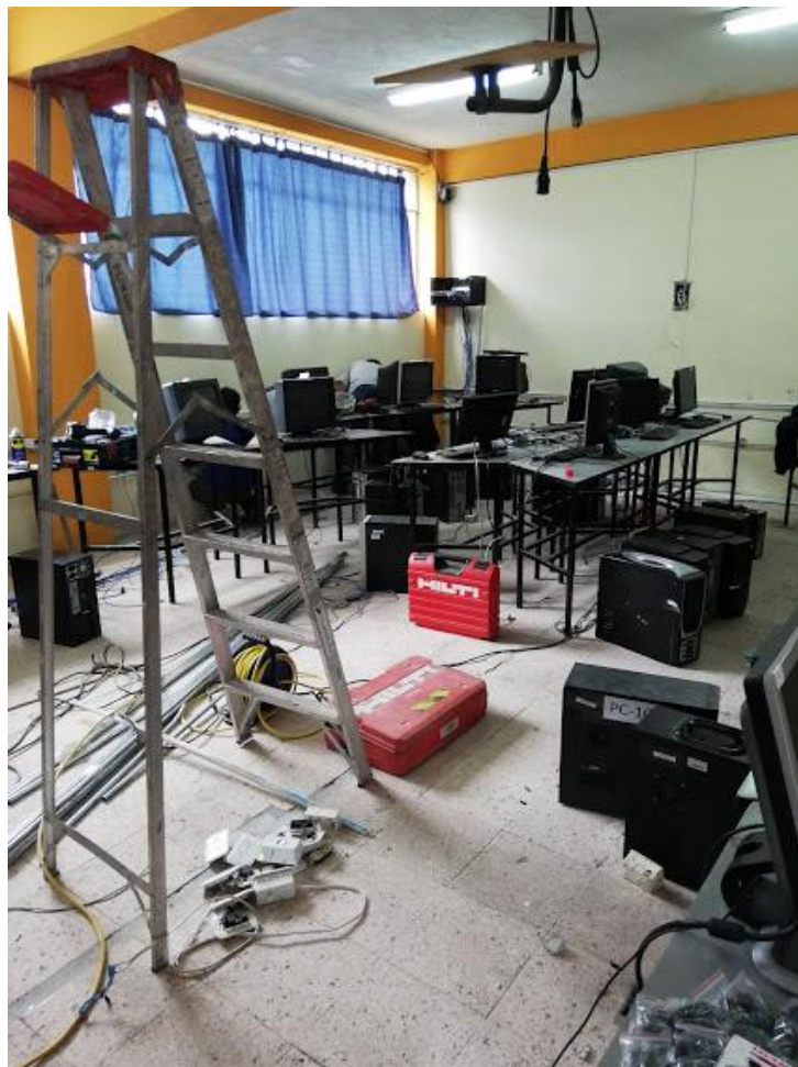
Figura 29 Desmontaje de la red de datos obsoleta
