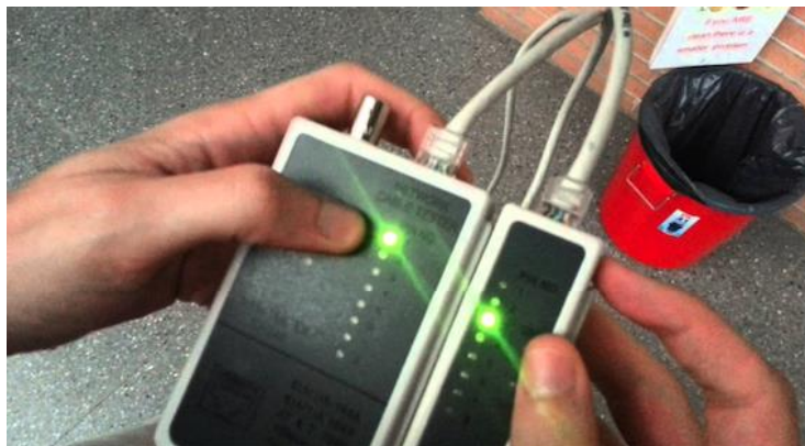
Figura 44: Prueba funcionamiento cable UTP
