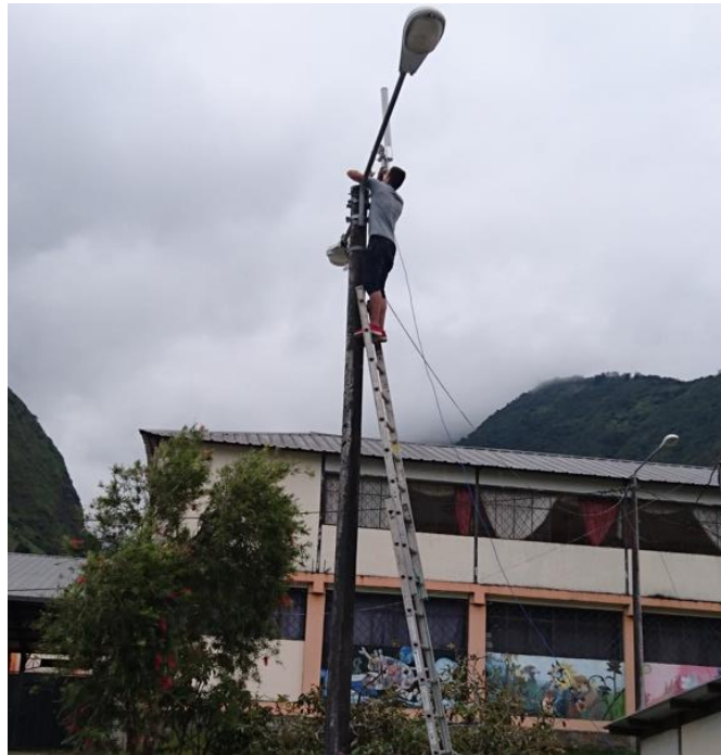
Figura 32: Instalación de la antena de alta potencia
