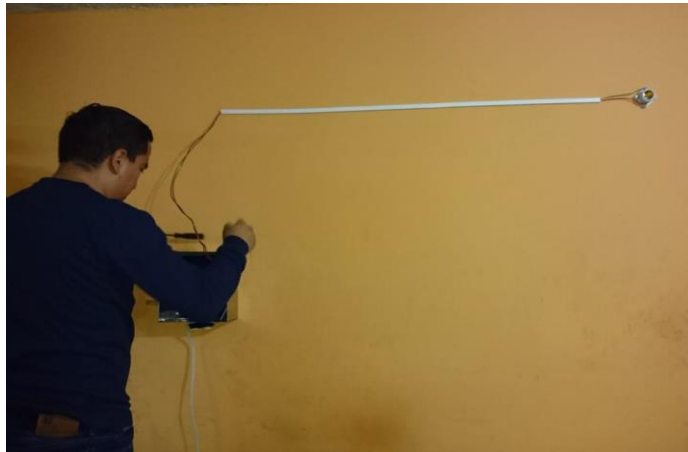
Figura. 4.14. Instalación del cableado
