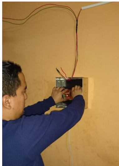
Figura. 4.15. Instalación de placa
