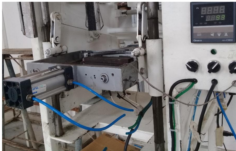
Figura 4.14. Instalación de conexiones eléctricas y electrónicas
