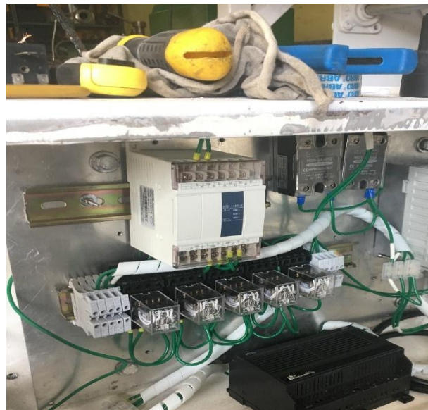
Figura 4.11. Instalación de relés
