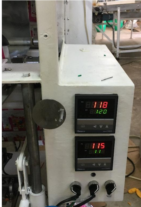
Figura 4.15. Instalación panel de control Fuente: Elaborado por el autor
