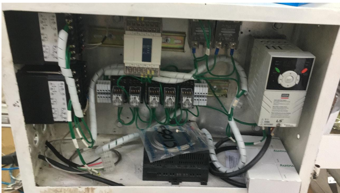
Imagen 10: Parte Interior del Tablero
