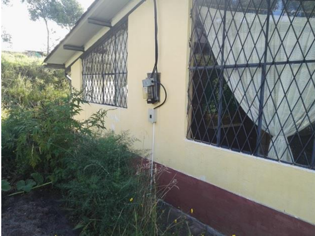
Fig. 4.10 Instalación de caja térmica Fuente: (Elaborador por el autor)
