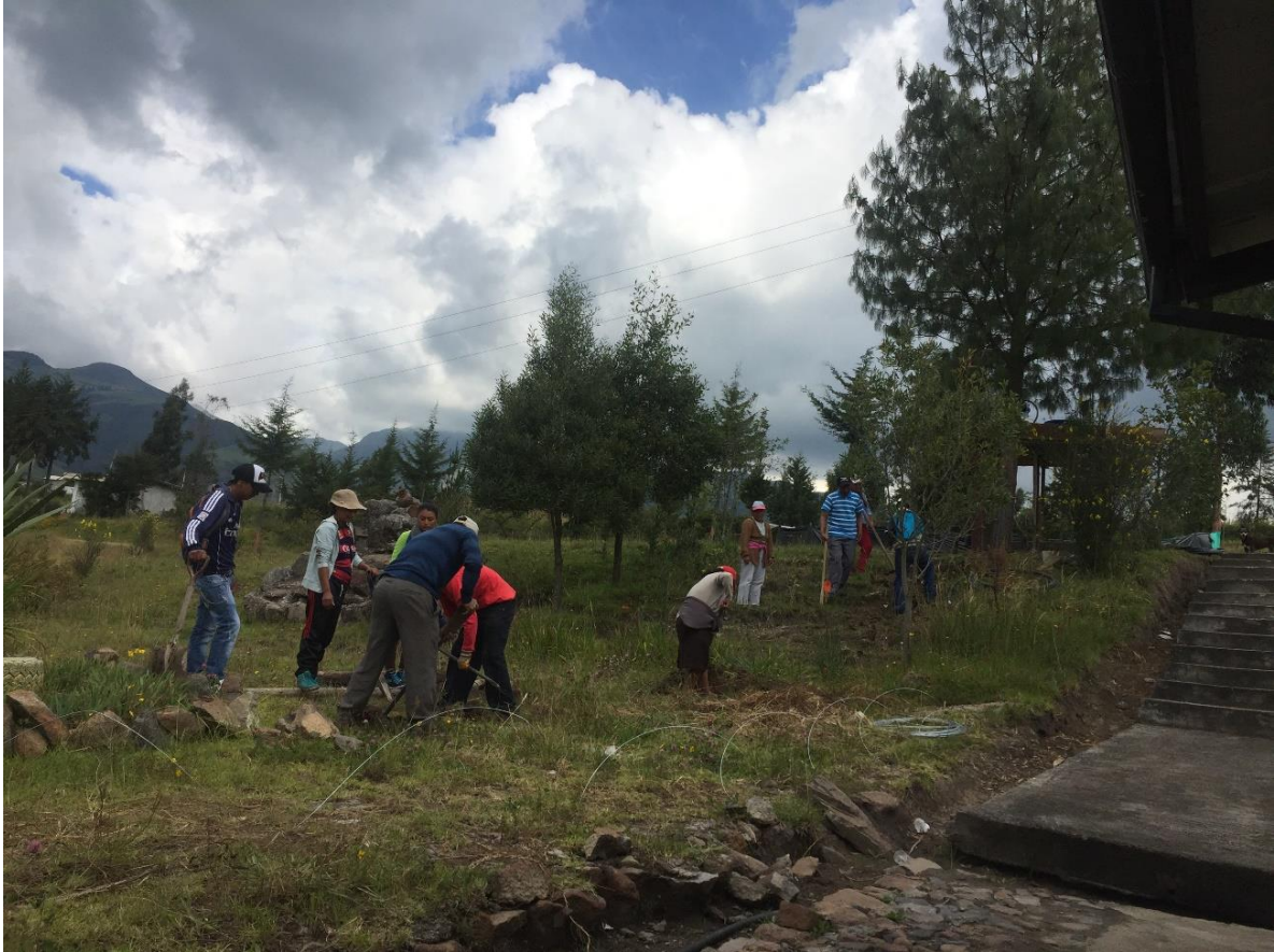
Fig. 4.3 Zanjado para tendido de tubería principal Fuente: (Elaborado por el autor)
