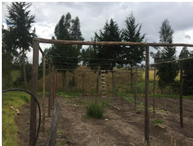
Fig. 4.5 Colocación de tendido aéreo Fuente: (Elaborador por el autor)
