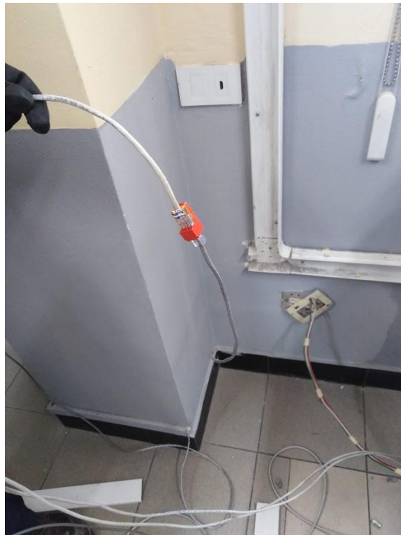
Figura. 4.9. Desmontaje del Cableado Fuente: Elaborado por el Autor
