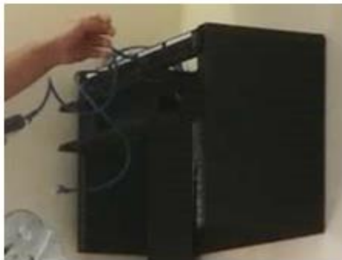
Figura. 4.12. Instalación del Rack Fuente: Elaborado por el Autor
