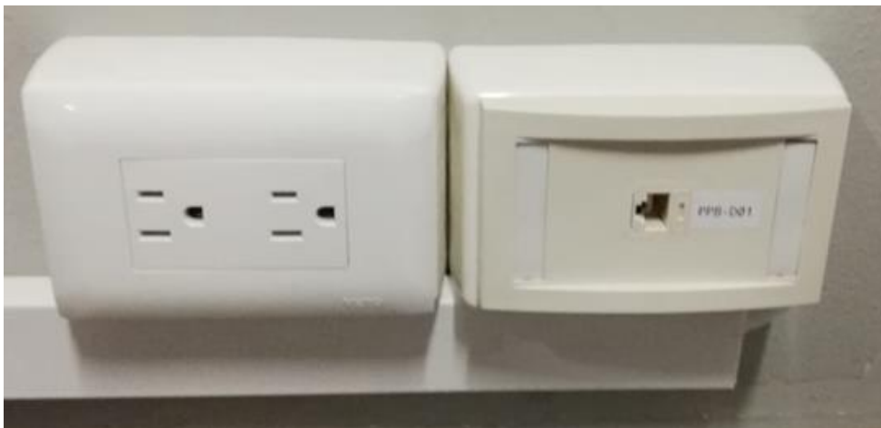
Figura. 4.13. Punto de Red Etiquetado
