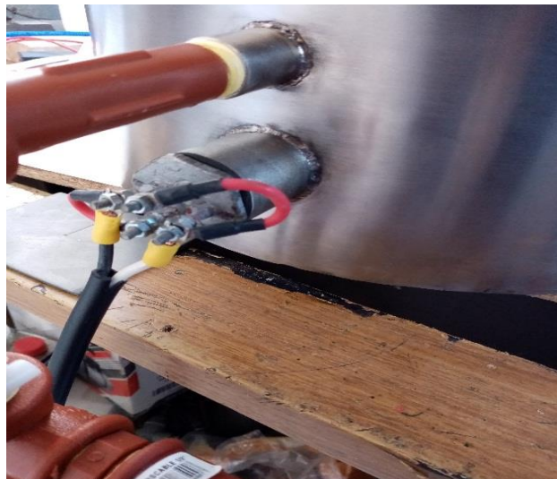
Figura 4.48. Instalación de la niquelina
