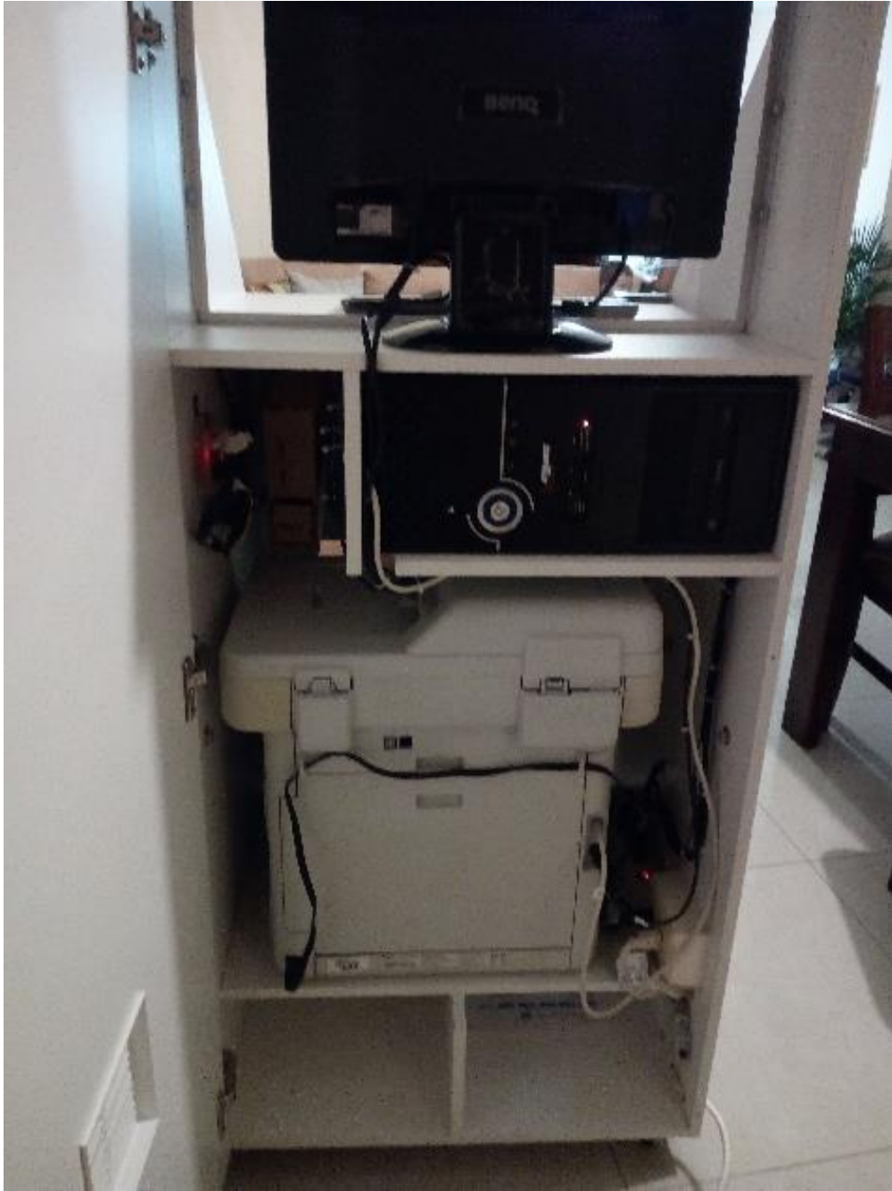
Figura. 3. 51. Vista del montaje de los equipos en el interior del kiosco
