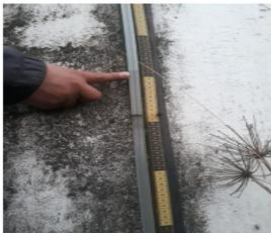
Figura 3.1 Forma de medición de los niveles de agua
