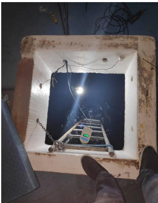
Figura 4.15 Vista Interior del tanque de abastecimiento
