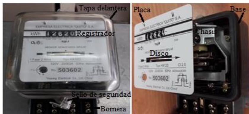
**Figura. 1.4.** Medidor electromecánico bifilar
