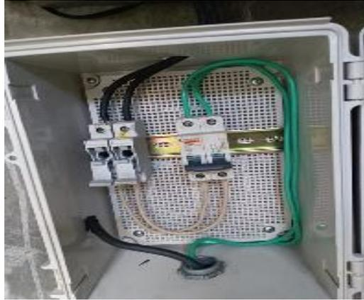
**Figura 0.2 Reemplazo de caja térmica y reactivación de energía eléctrica**
