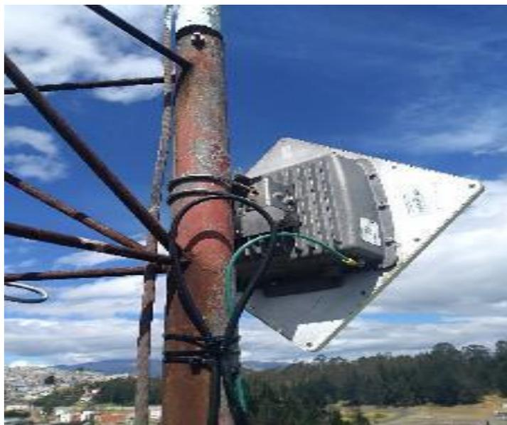
**Figura 0.23 Instalación de antena de receptora (Rx)**
