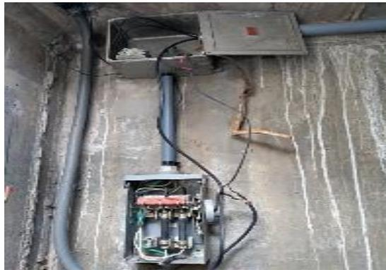
**Figura 0.1** Caja térmica en mal estado
