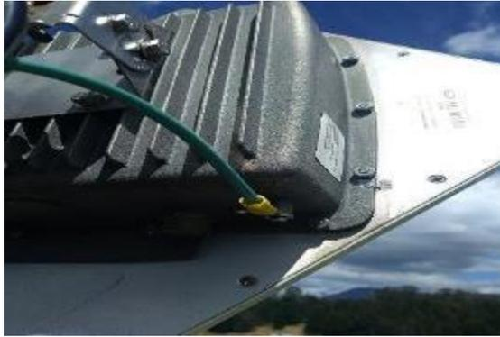
**Figura 0.24 Carcaza metálica con puesta a tierra**
