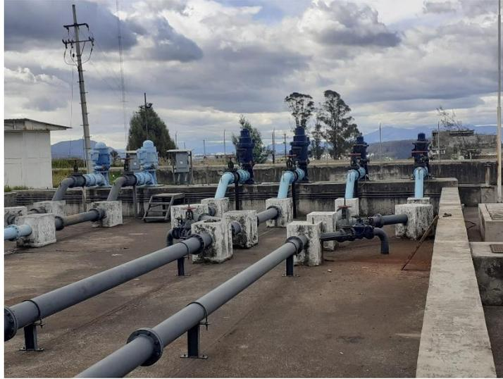
**Figura 0.43 Bombas de abastecimiento de agua para tanque retro-lavado planta Puengasí**
