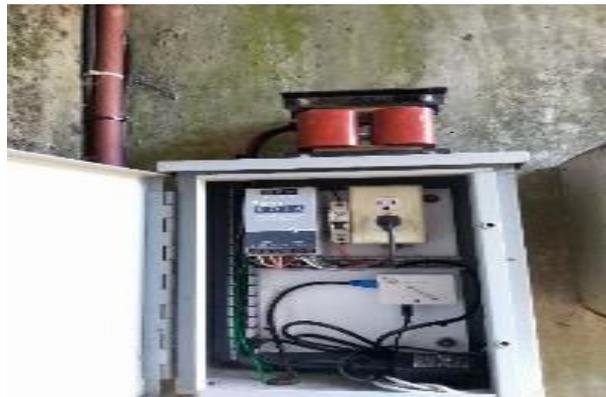
**Figura 0.7 Instalación de transformador de tensión 420V a 110 V**
