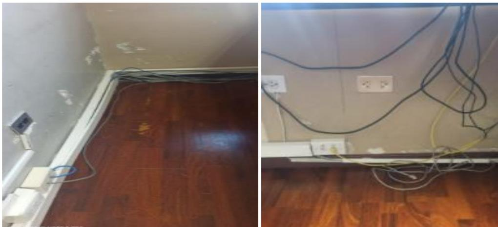
*Figura 15.* Planta baja tendido de cable utp cat 5e
