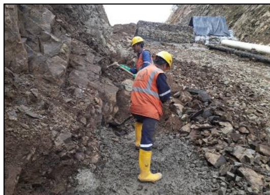
Imagen 2. Limpieza y reconfiguración del derecho de vía.
