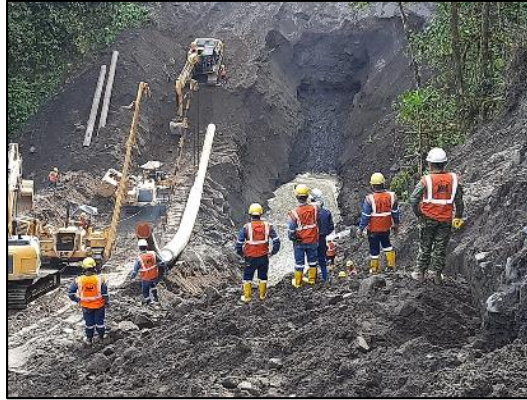
Imagen 3. Construcción de variantes de tubería.
