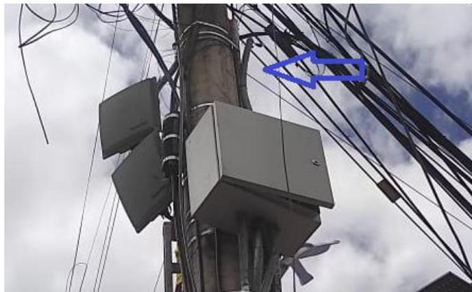
*Nota.* Instalación de soportes para anclaje de antenas RFID y Radioenlace. *Tomado de Autor*
