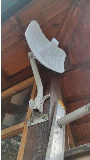
*Nota. Anclaje de antena en el sitio (AntenaCasa). Tomado de Autor*
