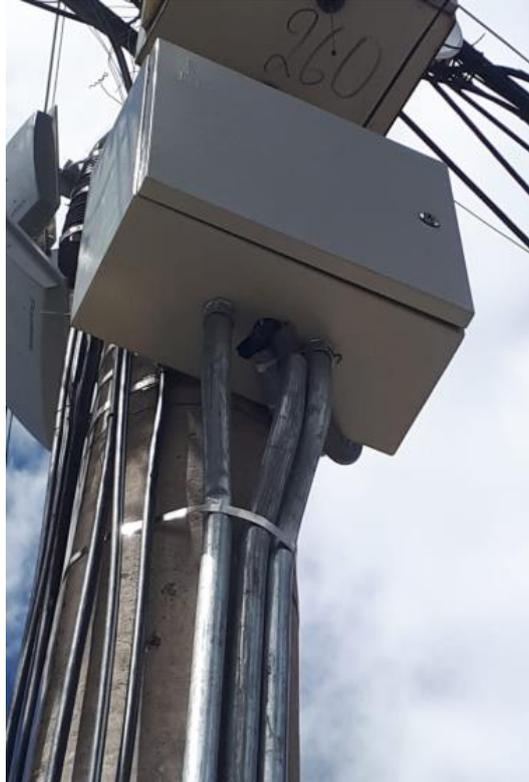
*Nota.* Instalación de gabinete metálico para proteger equipos. *Tomado de Autor*
