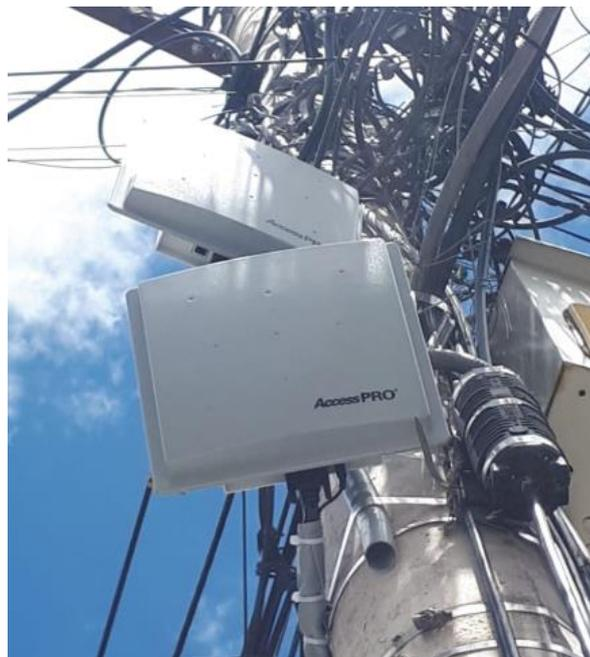
*Nota.* Anclaje de antenas RFID en el sitio (AntenaBolardo). *Tomado de Autor*
