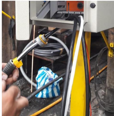
Figura 4. 11. Conexión de los acoples rectos
