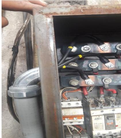
Figura 4. 18. Conexión del codo para la manguera de funda sellada
