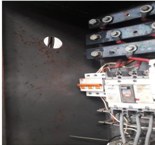
Figura 4. 16. Perforación de las 3 barras de alta tensión
