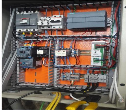
Figura 4. 20. Realizar las conexiones eléctricas en el tablero de potencia
