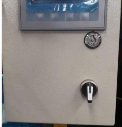
Figura 4. 14. Conexión del selector (automático manual)
