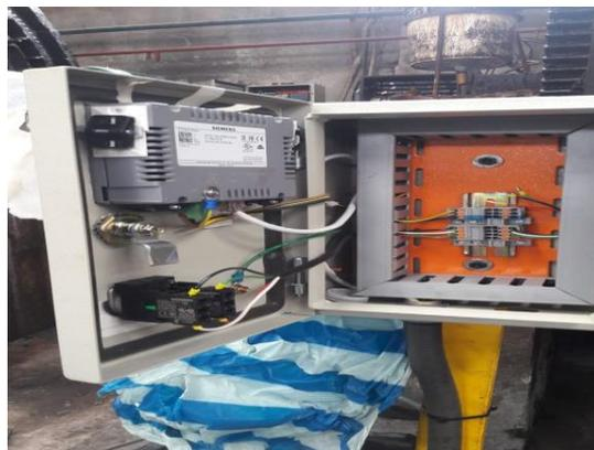
Figura 4. 21. Realizar las conexiones eléctricas en el tablero de control
