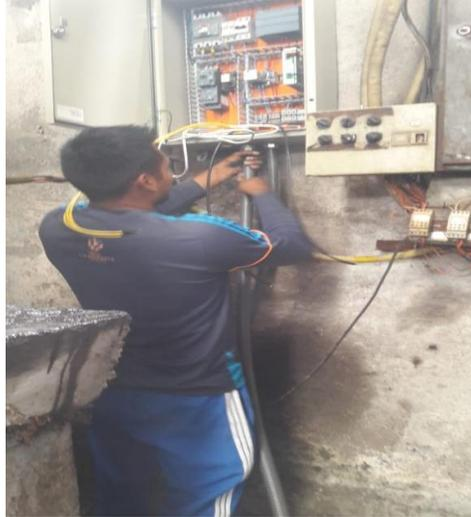
Figura 4. 12. Conexión de la manguera de funda sella
