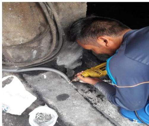
Figura 4. 13. Conexión de abrazaderas tipo u
