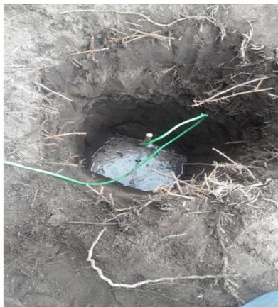
Figura 4. 9. Realizar una tierra común exclusiva para el tablero”
