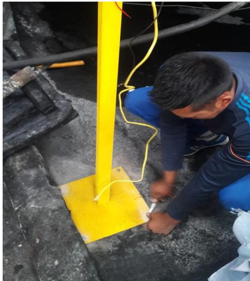
Figura 4. 7. Colocar un soporte exclusivo para el tablero de control
