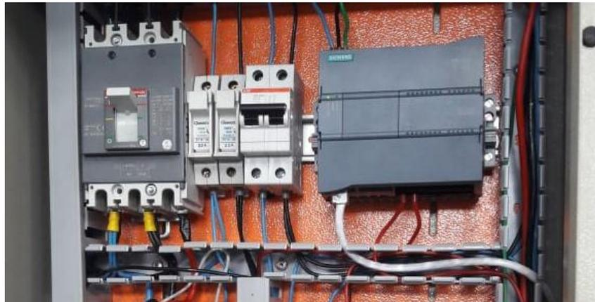
Figura 4. 23. Funcionamiento del PLC y HMI
