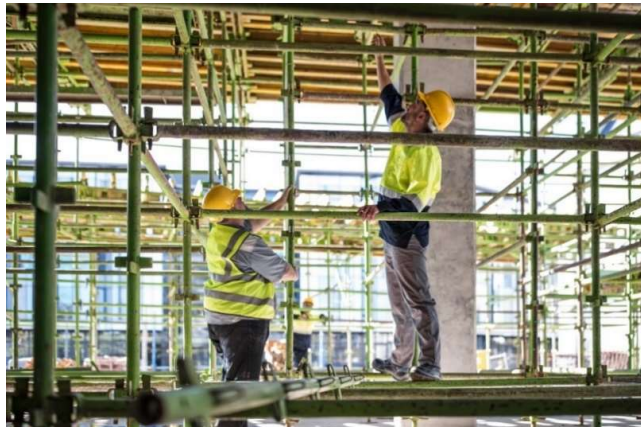
Figura 39. Armado de andamio
