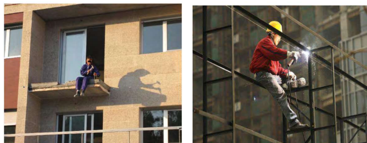
Figura 21. Riesgo por no utilizar el EPP de forma adecuada
