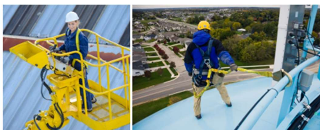
Figura 31. Trabajos en plataformas en altura
