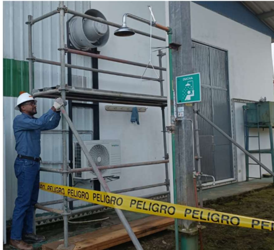
Figura 37. Inspección de andamio antes de ser utilizado
