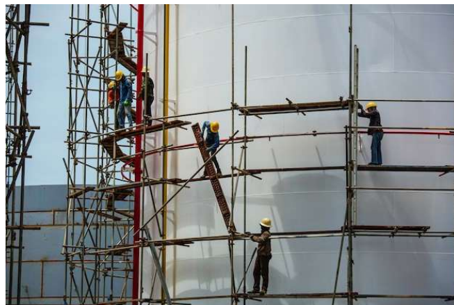
Figura 38. Armado de andamios de un tanque de almacenamiento de agua de formación
