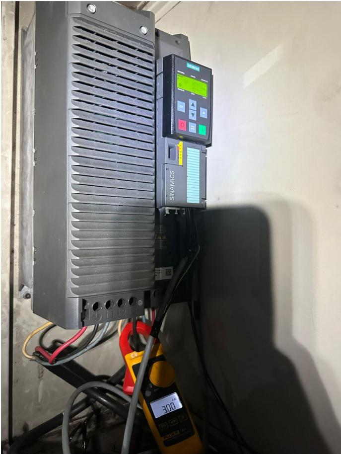
Con esta prueba se logra comprobar que el valor de corriente que envía el variador de frecuencia hacia el PLC es el correcto, se puede apreciar que como ejemplo se tomó el valor que de 3ª que marcaba en ese momento, por lo que se procede a escalar dicho valor en la programación, en este caso los límites son de 0 a 12 y da como resultado 3.003 A, como muestra la figura 61.
