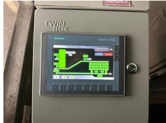
Las pruebas de funcionamiento tuvieron ciertos detalles en demora para poder escalar los valores y puedan ser comprobados que estén enviando las medidas correctas, al colocar el PLC nuevo se tuvo que volver cablear todo el circuito debido a que los modelos no eran iguales.
