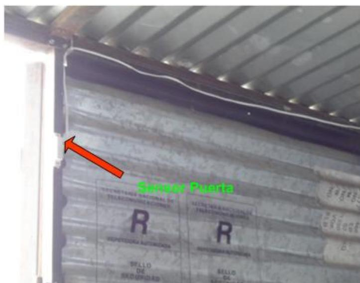
**Ilustración 43** Instalación de sensor de puerta en la caseta.
