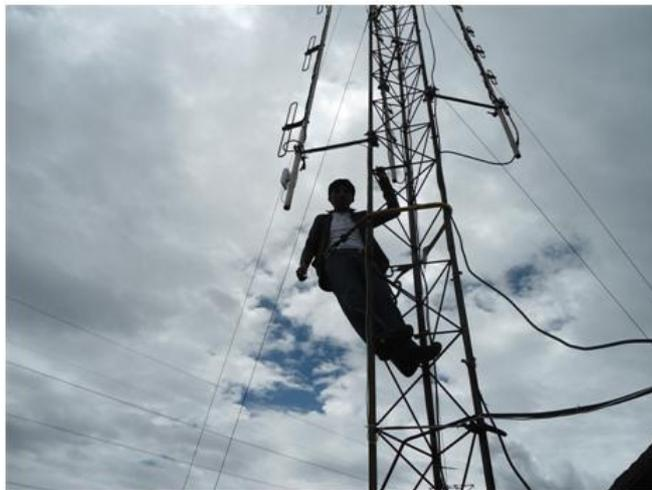
**Ilustración 39** Instalación de antena en torre de comunicaciones
