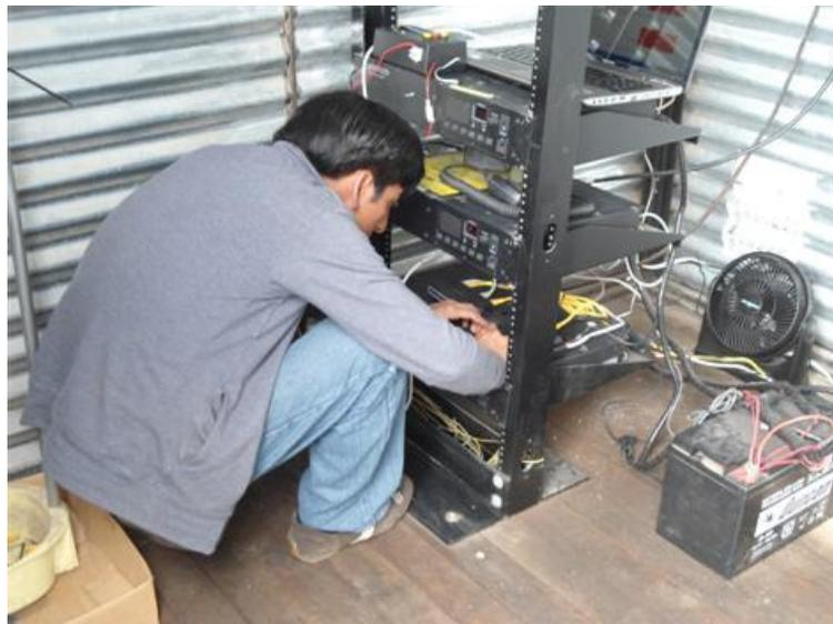
**Ilustración 45** Instalación de dispositivo de telemetría (Ditec)
