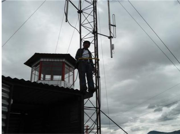
**Ilustración 38** Instalación de antena en torre de comunicaciones
