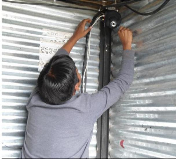
**Ilustración 50** Tendido de cables de red y alimentación de cámara.
