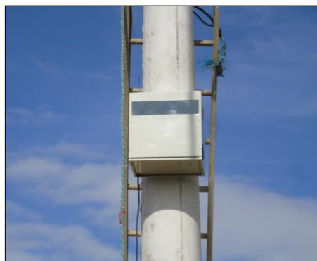
Figura 3.34 Instalación final del prototipo
