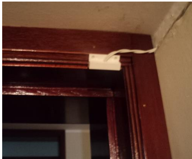
Figura No.3.27 Implementación del sensor magnético 2 (puerta del baño)
