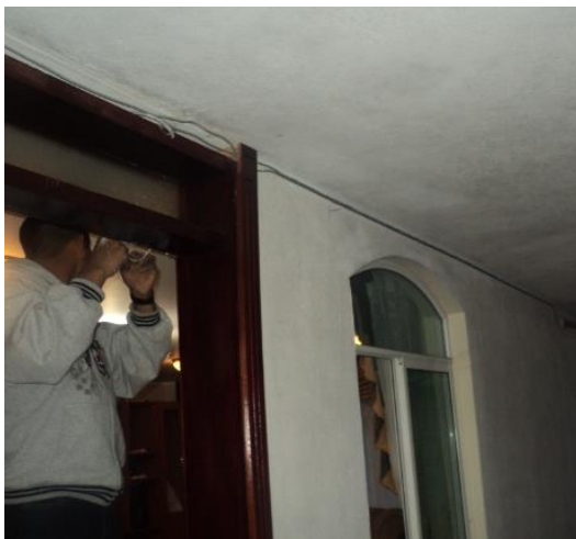
a) Conexión de los sensores puerta principal
