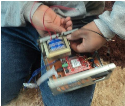
a) Conexiones en el transformador.
