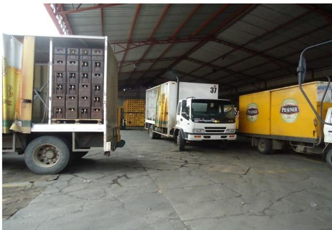
El proceso de cargue y descargue de la mercadería se lo realiza mediante 2 montacargas, y en algunos caso se lo realiza en forma manual, se identificó que en el sector donde se realiza la descarga el piso tiene grietas lo cual puede generar y ocasionar accidentes.
