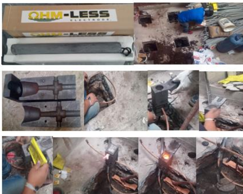
Ilustración 3.10: Pasos a seguir para la puesta a tierra con electrodos
