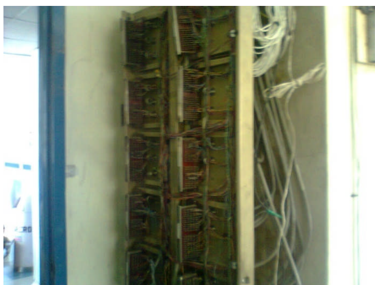
Figura 2.1: Distribuidor de telefonía análoga en uso en el HE-1
