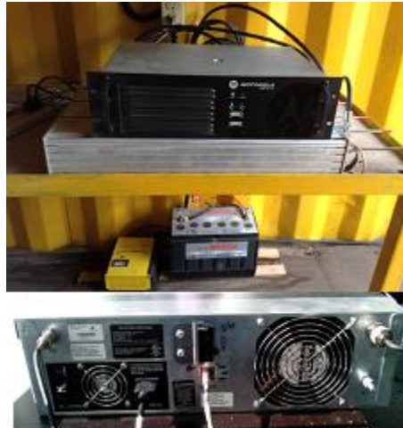
Figura 3.11 Equipos de repeticion y fuente Cerro Pichincha
