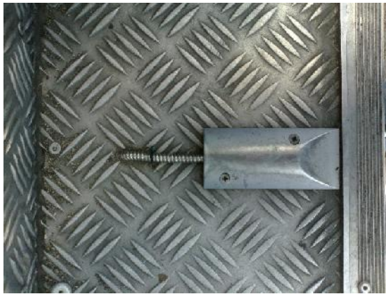
ILUSTRACIÓN 4. SENSORES DE PUERTAS FUENTE: (TRANSLATINOS & AUTOR, 2013)
