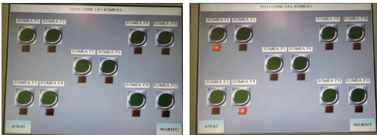
a) b). Figura 54- Pantalla de mando de bombas
