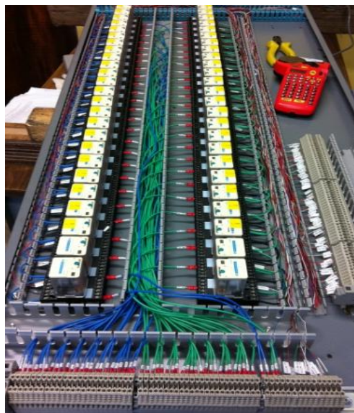
Figura 49. Cables de interface.
