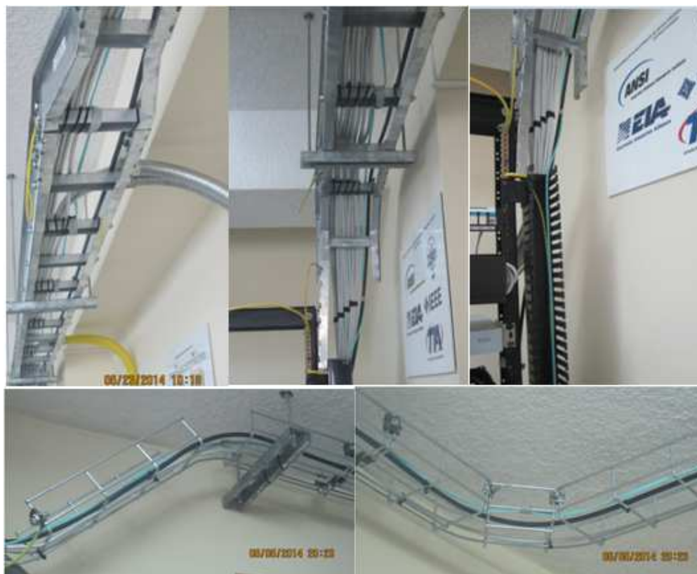
Figura 3.20 Tendido de la fibra por la Estructura Metálica 39
