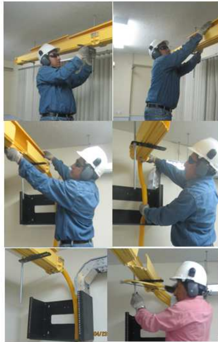
Figura 3.18 Instalación del fiber sobre 37
