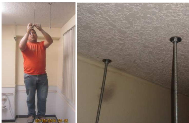
Figura 3.11 Instalación de soportes 32
