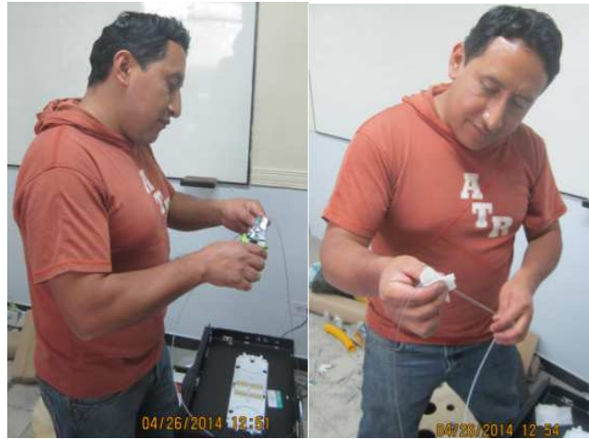
Figura 3.24 Eliminar el revestimiento secundario y limpieza de las fibras 43
