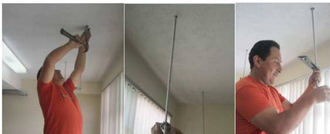
Figura 3.16 Instalación de soportes de fiber runner 36
