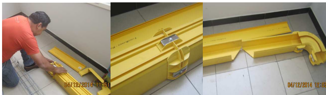
Figura 3.17 Instalación previa del fiber runner y sus accesorios 36
