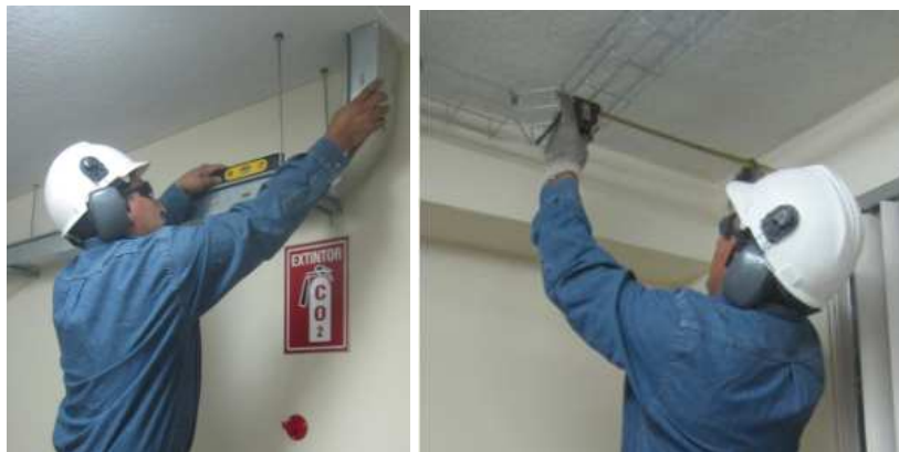
Figura 3.13 Medidas y nivelación de las bandejas metálicas 33
