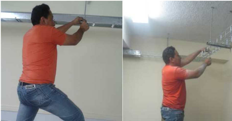
Figura 3.12 Montaje de bandejas 33
