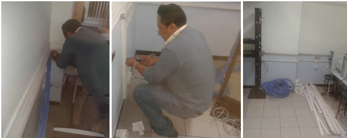
Figura 3.7 Retiro de la red en mal estado y obsoleto 29
