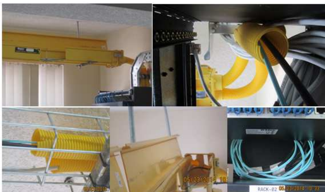
Figura 3.21 Tendido de la fibra por la estructura de fiber runner 40
