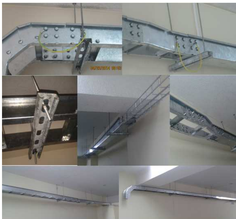
Figura 3.14 Vistas de la estructura metálica terminada 34
