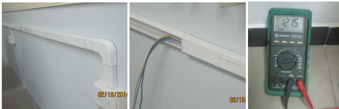
Figura 3.9 Instalación y verificación del nuevo tendido eléctrico 30
