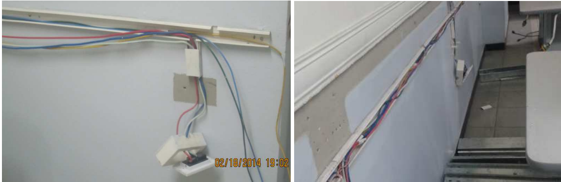
Figura 3.8 Retiro de los accesorios eléctricos en mal estado. 29
