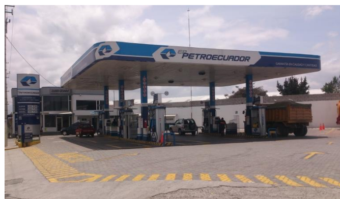
Fig. 3.38 Estación de servicios PETROECUADOR.
