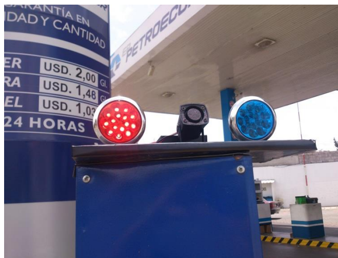
Fig. 3.41 Alertas visuales y audibles del DIV instaladas en la estación de servicio PETROECUADOR.
