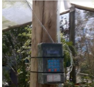
Figura 23. Instalación del control de riego.
