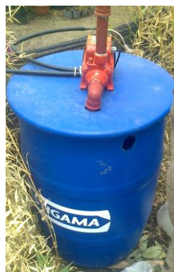
Figura 25. Instalación de la bomba y tanque de agua.
