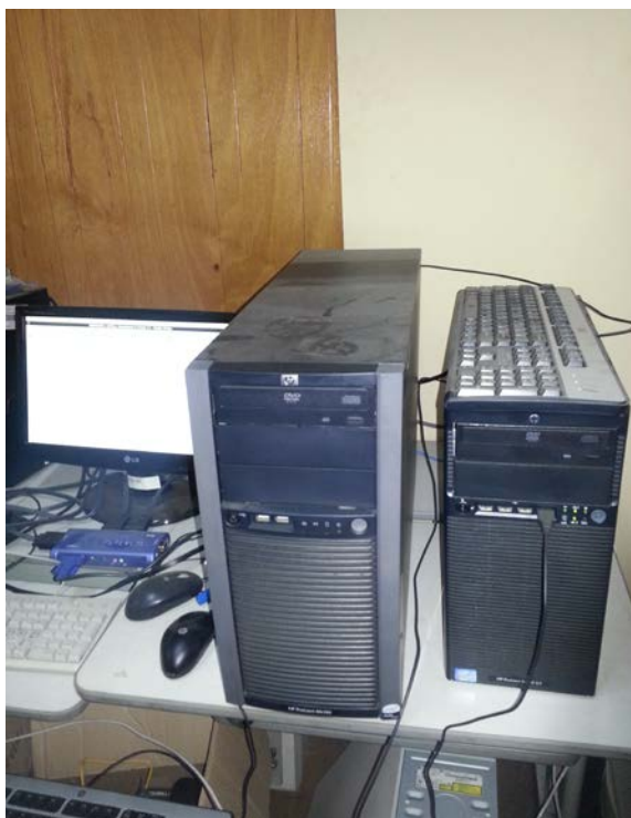
Fig N°- 27: Servidor donde se encuentra la aplicación instalada de EasyHotSpot Autor: Xavier Martínez
