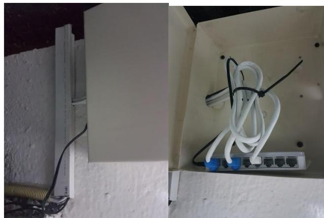
**Figura 101 Cableado del sistema de video vigilancia y conexión del Switch con cada cámara**
