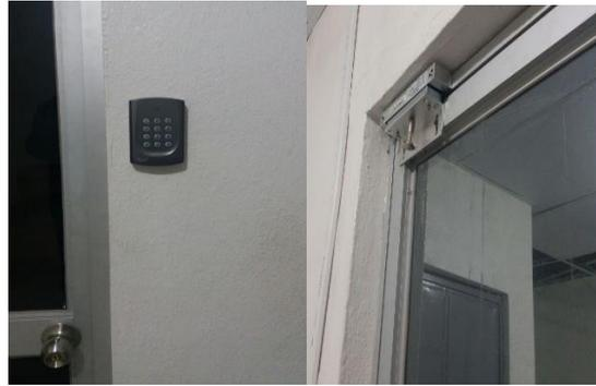
**Figura 100 Colocación de control de acceso y cerradura electromagnética**
