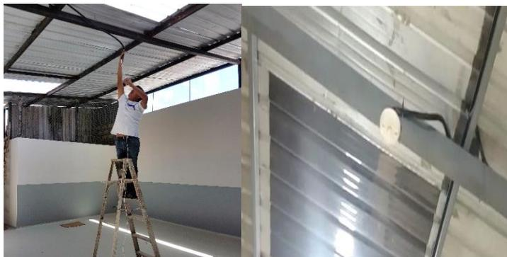
**Figura 93 Instalación y conexión del detector de temperatura**
