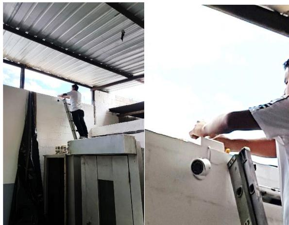
**Figura 105** Ubicación de cámara IP bala en el área de producción
