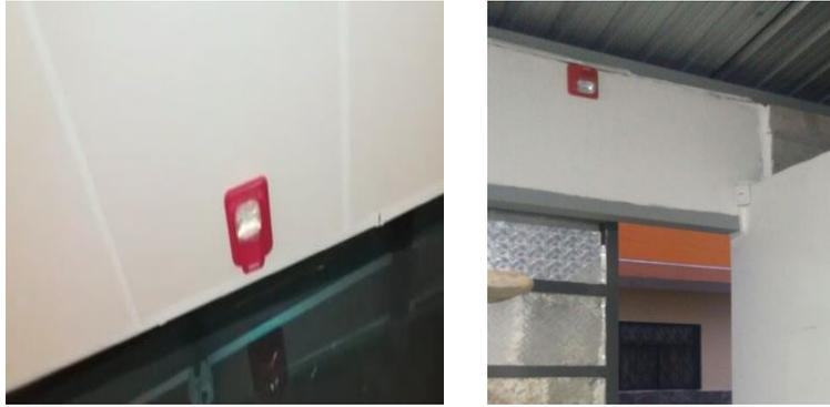
**Figura 96 Colocación de sirenas estroboscópicas**
