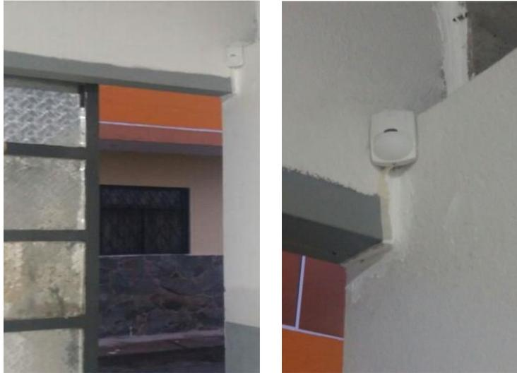
**Figura 98 Colocación sensor de movimiento producción**
