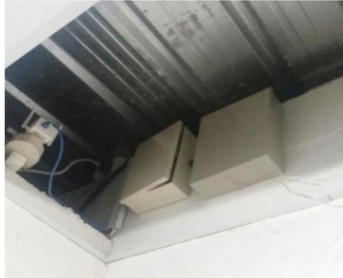
**Figura 99 Cajas de conexión del sistema de video vigilancia IP y sistema de seguridad**
