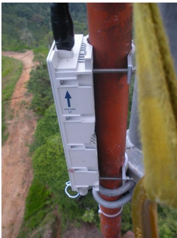
***Fotografía de la unidad externa del radio sujeta a la torre.***
