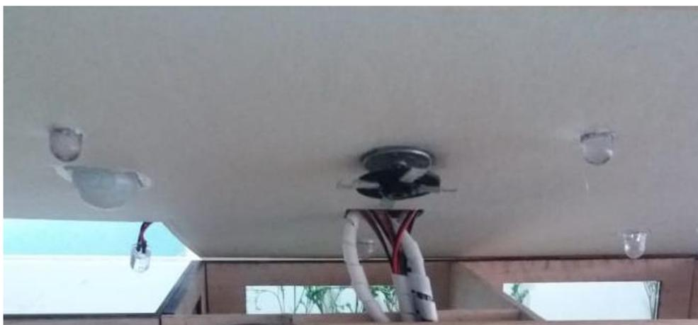
**Figura 32** Instalación de iluminación, ventilación y sensor PIR
