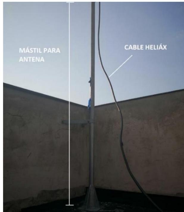
**Figura 4.34.- Soporte para la antena omnidireccional**
