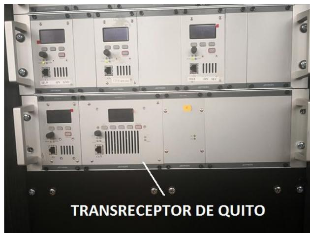
**Figura 3.21.-Trasreceptor JOTRON en 119.7 MHz**
