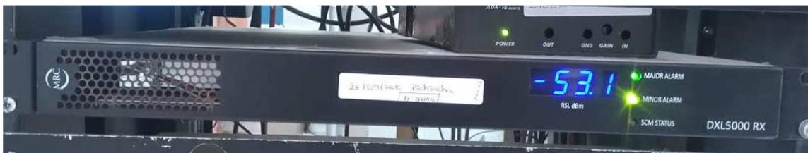
Figura 3.10: Receptor digital de la señal de televisión en el cerro Pichincha.
