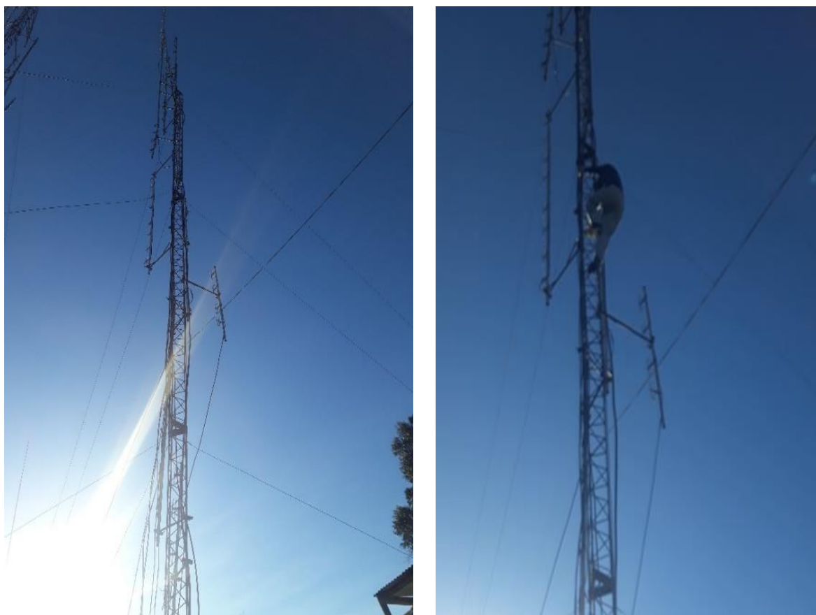
Figura 4.7 Instalación de la Antena
