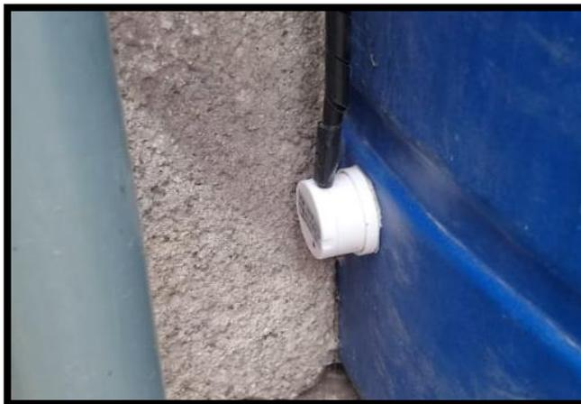
**Figura. 4.17. Sensor ultrasónico de nivel de agua**
