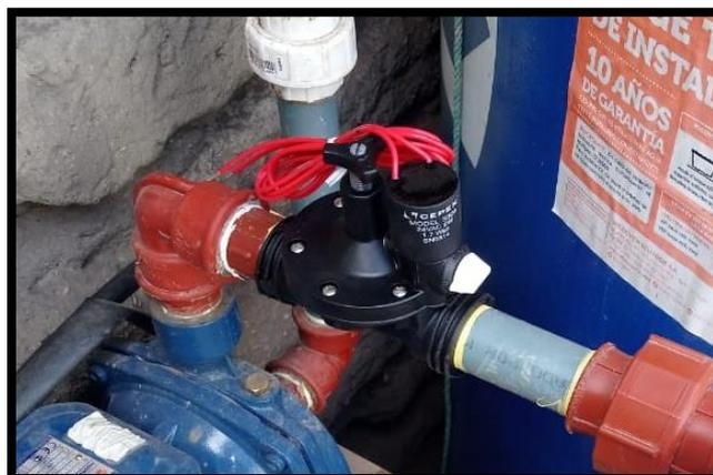
**Figura. 4.8. Conexión de la electroválvula**
